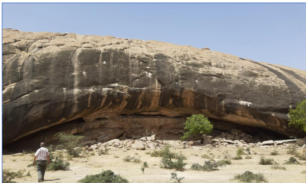
Figure 34 : Exemple d'une fracture de socle observée en surface dans la région du Guéra [David Ramel].
